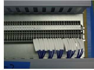
写真 24. スプリング端子への配線
